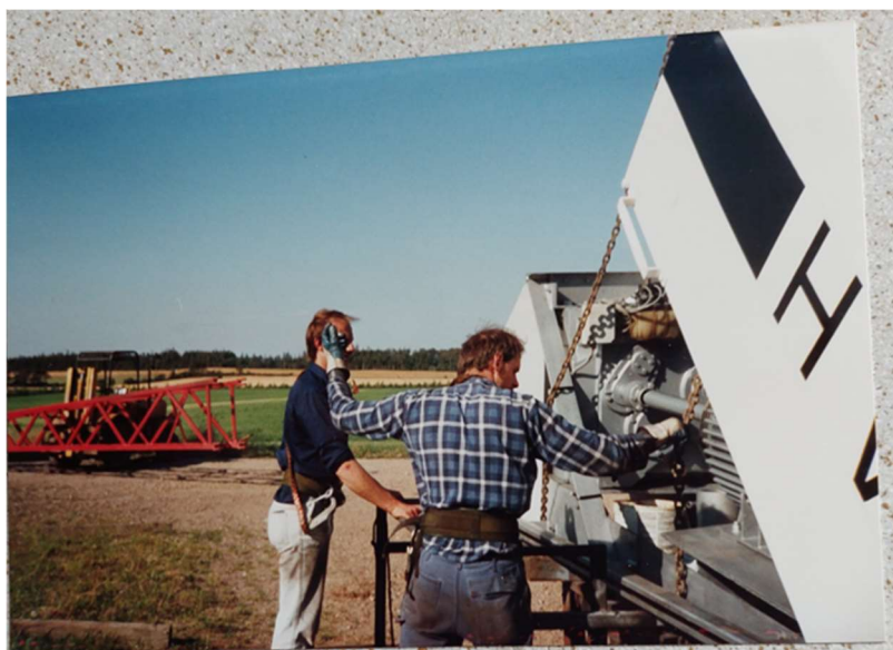
FIGUR 15: ARBEJDSITUATION MED BYGNING AF MØLLE
