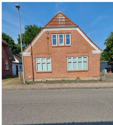
FIGUR 35: HUSET PÅ MØLLEVEJ SOM DET SER UD I DAG
