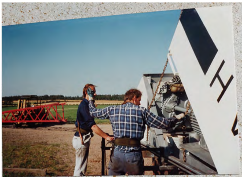
FIGUR 92: ARBEJDSITUATION MED BYGNING AF MØLLE
